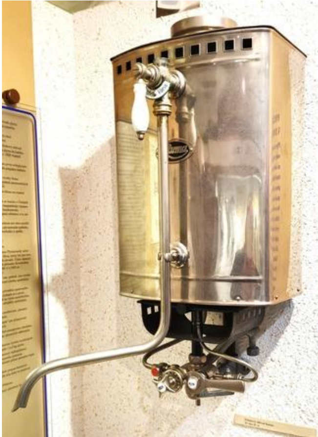
Obr. 5 Plynový průtokový ohřivač KARMA, dvacátá léta 20. století. Výtok se přepínal mezi vanou a sprchou ventilem nahoře. (Foto a copy: autor. Plynárenské muzeum, Pražská plynárenská a.s.)
