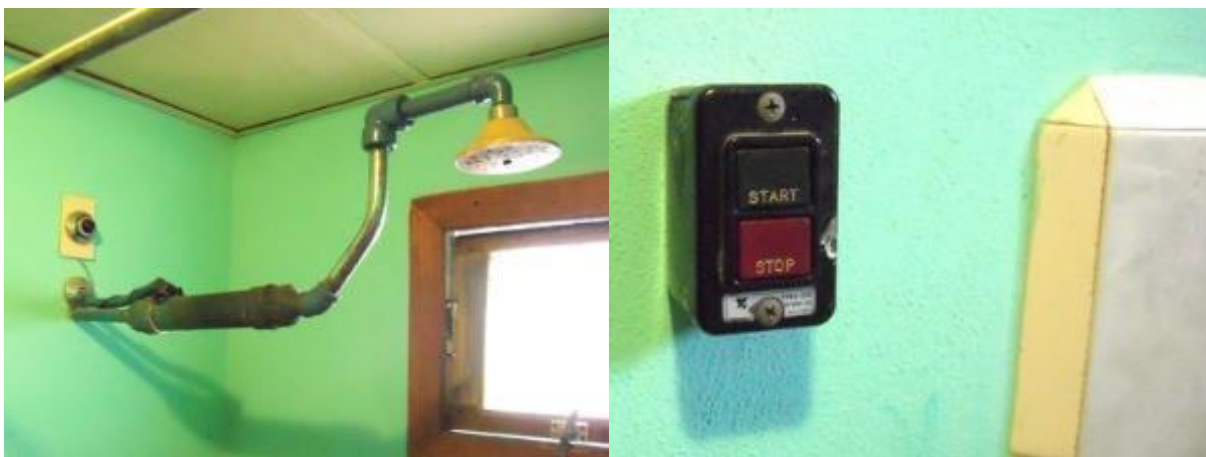
Obr. 14 Využití této sprchy při troše znalostí rizika smrti od elektrického proudu vyžaduje odvahu a víru v trvalé štěstí. Zvláště když se ohřev vody zapíná a vypíná tlačítkem v těsném sousedství sprchy. (Foto a copy autor. Kuba, 2012)
