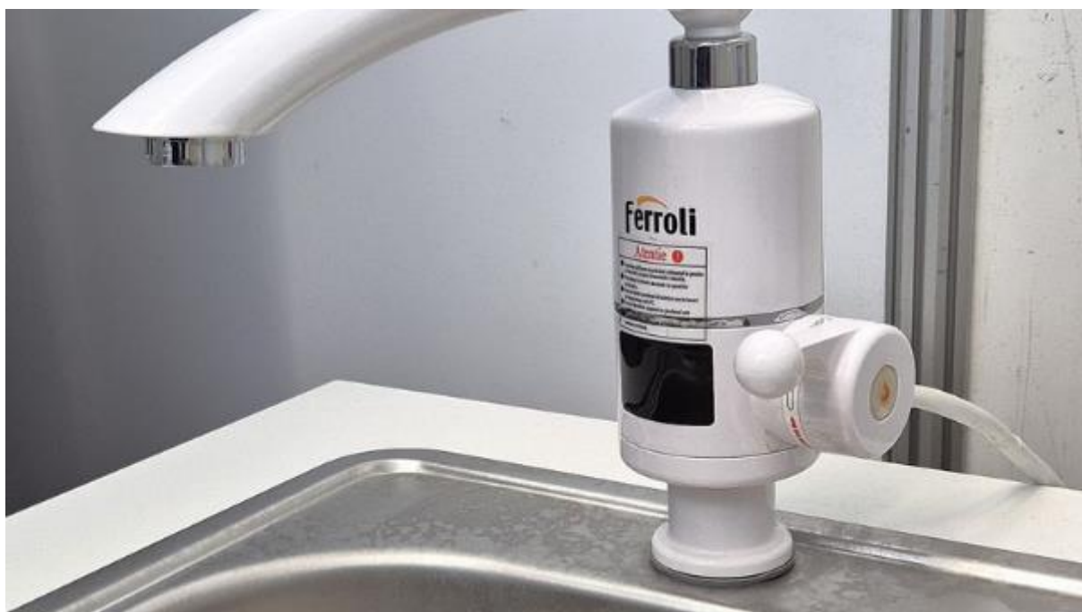
Obr. Průtokový ohřívač vody integrovaný do směšovací baterie na dřezu v zázemí stánku TZB-info na výstavě Infotherma 2025
