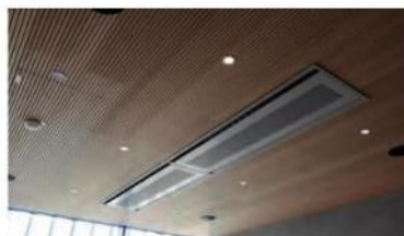
Stropní větrací jednotka ComfoAir Flex s flexibilním potrubím je navržena speciálně pro menší domy a byty. ZEHNDER ↗
