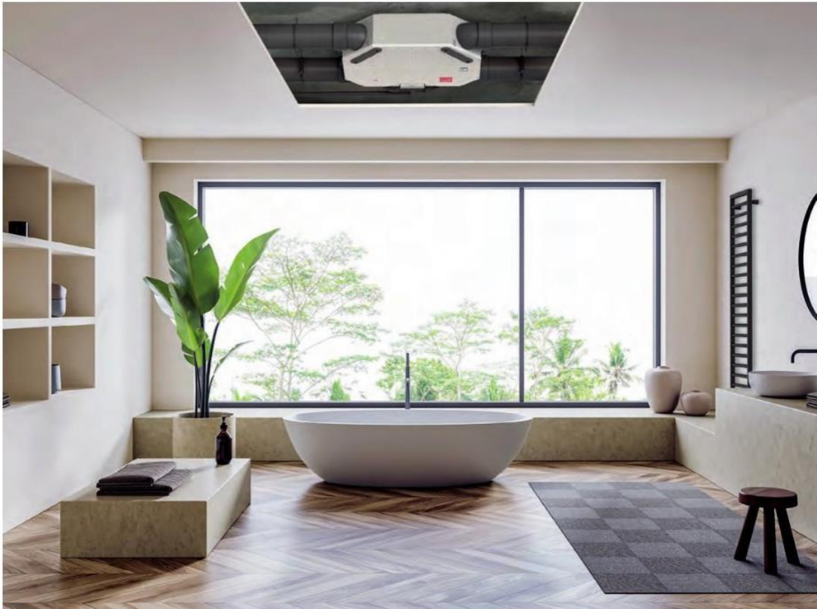
Stropní větrací jednotka ComfoAir Flex s flexibilním potrubím je navržena speciálně pro menší domy a byty. ZEHNDER ↗
