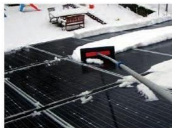
Sníh, který z panelů ne-sklouzne díky jejich sklonu, je nutné odstranit, aby fotovoltaika mohla fungovat. LA SOLAR GROUP
