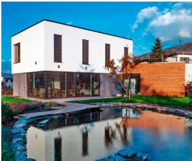
Dvoupodlažní zděná monolitická stavba pasivního domu, projekt Cholupice , k základní hmotě stavby je nasunuta jednopodlažní část s relaxací a wellness, www.kubus.cz
