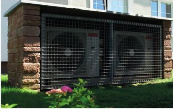
Venkovní jednotku tepelného čerpadla lze zajistit obestavbou z betonových prvků. CS BETON
