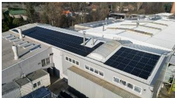
Fotovoltaická elektrárna v Dražicích
