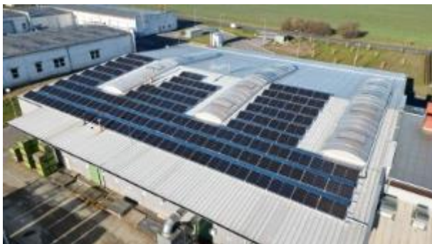
Fotovoltaická elektrárna v Luštěnicích
