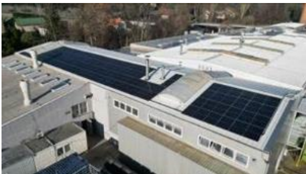
Fotovoltaická elektrárna v Dražicích
