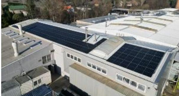
Střechu mořírny v Dražicích a lisovny v Luštěnicích pokrývá celkem 250 kusů fotovoltaických panelů Axitec o výkonu 400 Wp: na každé budově jich společnost Enado umístila 125 s předpokládanou roční produkcí elektřiny kolem 50,5 MWh (celkem tedy vyrobí 101 MWh). O efektivní využití vyrobené energie se starají třífázové symetrické střídače IN.Entity M o výkonu 50 kW.
