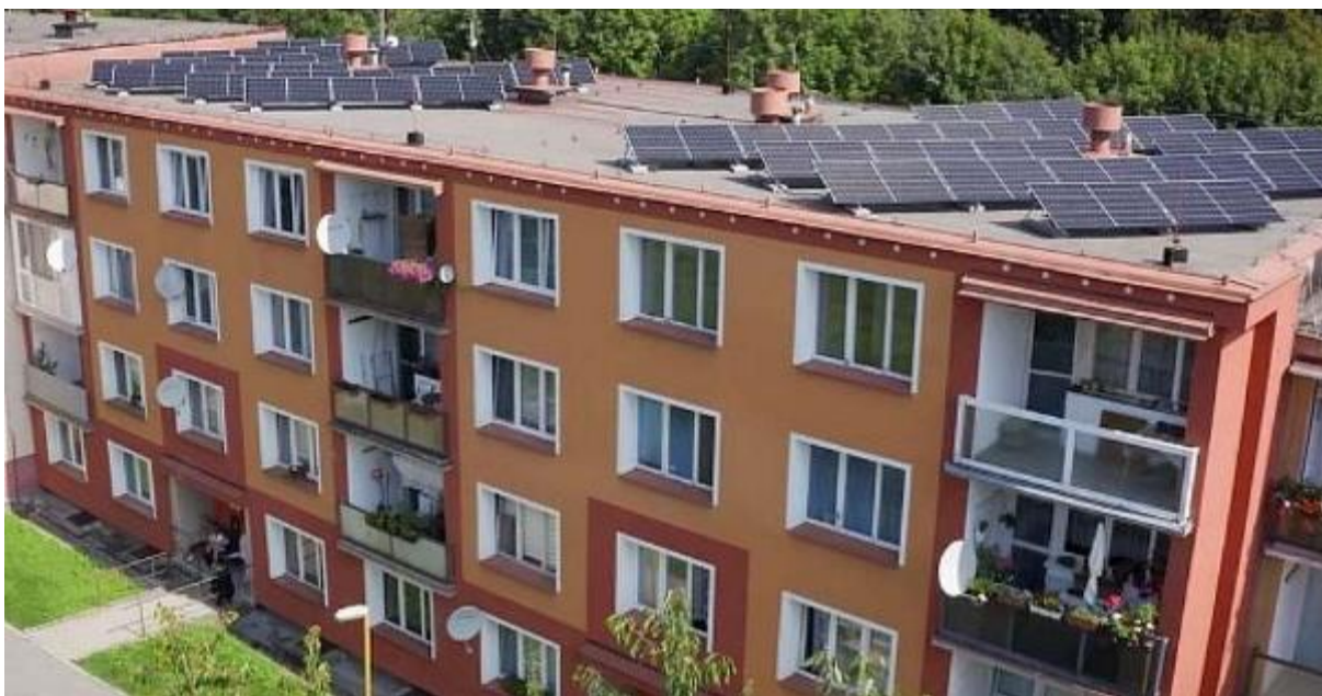
Fotovoltaické panely na bytovém domě v Lubech u Chebu
