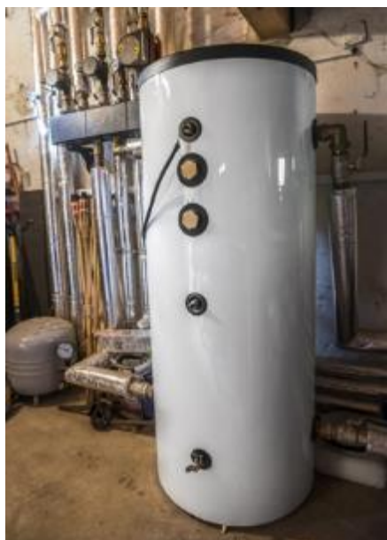
Akumulační nádrž NIBE UKV 300 pro přípravu teplé vody. Foto: DZ Dražice
