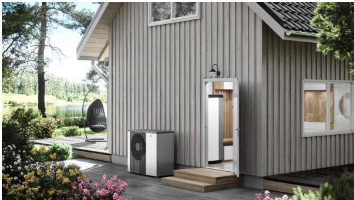
Tepelné čerpadlo NIBE F2120 s vnitřní jednotkou VVM S320
