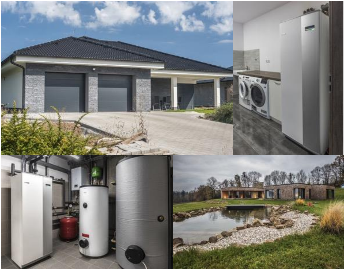
Novostavba rodinného domu v Červené Kostelci (tepelné čerpadlo systému vzduch-voda)
