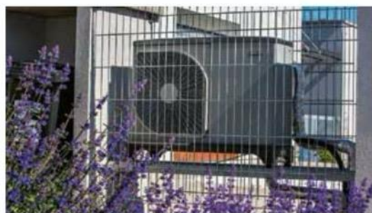
Venkovní jednotka tepelného čerpadla systému vzduch-voda NIBE F2040-6
