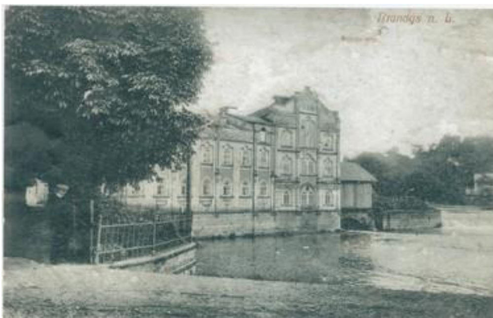
Obr. č. 6 – přístavba mlýna s provozem na turbínu Zdroj: kronika rodiny Antonína Šorela
