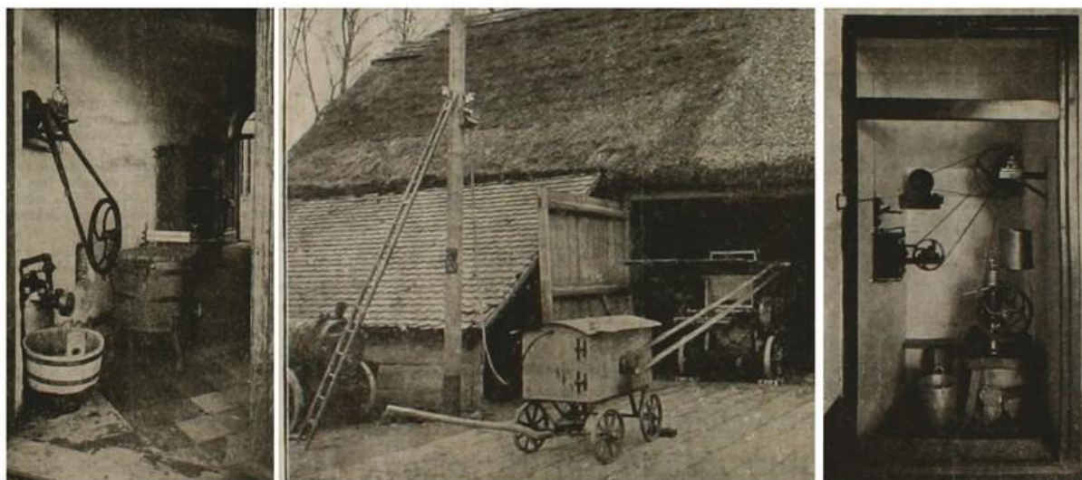
Obr. č. 2, 3, 4 – „Elektrifikace v obci Řevničov“
