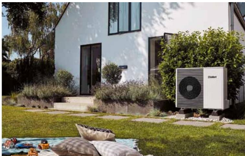
Tepelné čerpadlo v provedení vzduch/voda sestává z venkovní jednotky tepelného čerpadla vzduch/voda aroTHERM split a vnitřní jednotky uniTOWER split se záložním elektrokotlem (VAILLANT)
