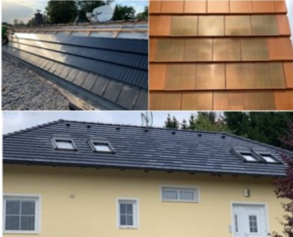
Ukázka instalací využívajících solární tašky.
