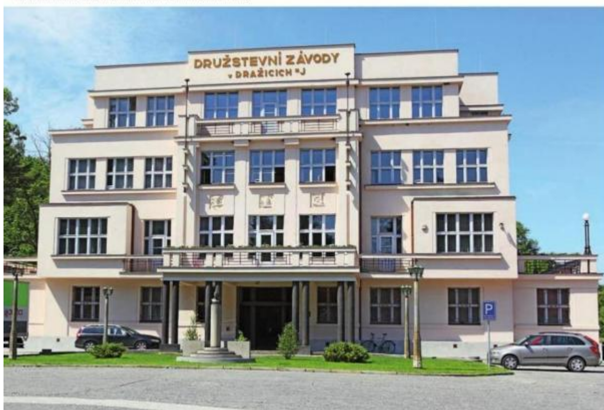
Administrativní budova DZ Dražice , funkcionalistická budova podle návrhu architekta Jiřího Krohý
